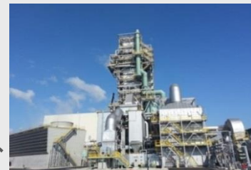
京浜バイオマス発電所 (燃料: 木質ペレット、パームヤシ種殻)
