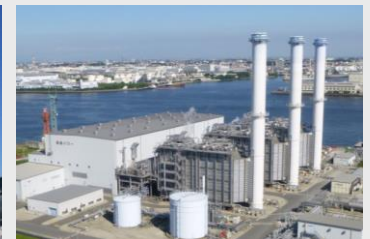
扇島パワーステーション (燃料: LNG)
