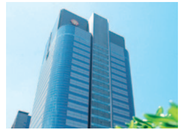
昭和シェル石油(株)本社
